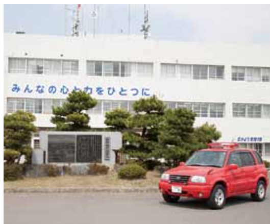
復旧・復興作業で活躍した指揮車にも車載型・無線装置を搭載
