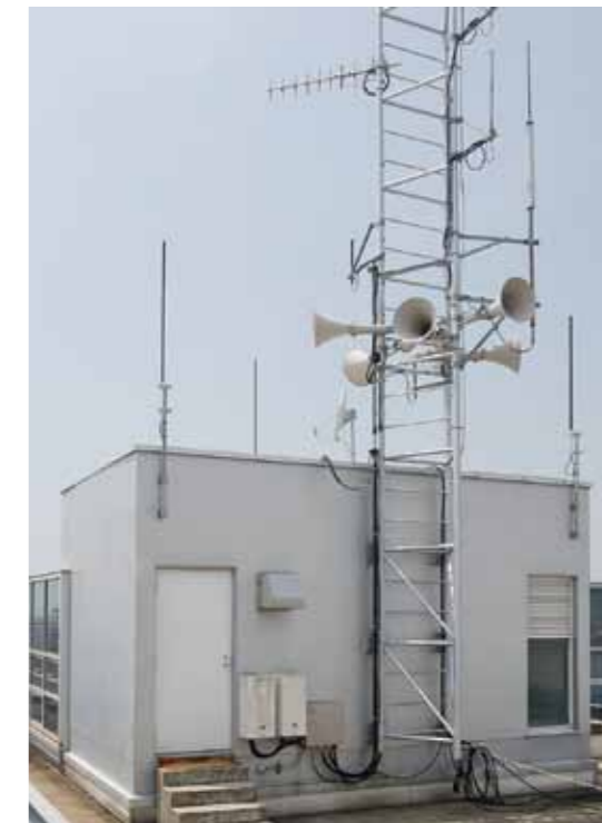
藍住町合同庁舎、屋上に設置された空中線設備（送信出力 10W・25m）
