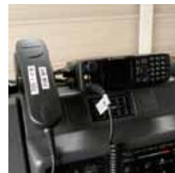
消防車両に搭載された車載型・無線装置
